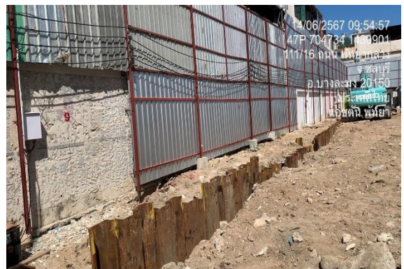
รูปที่ 5 Sheet Pile เพื่อป้องกันการชะล้างหน้าดิน
