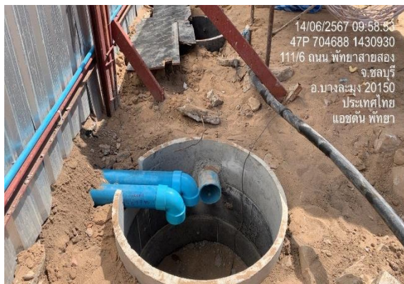
รูปที่ 6 บ่อพักน้ำ/ตักเศษตะกอนดิน
