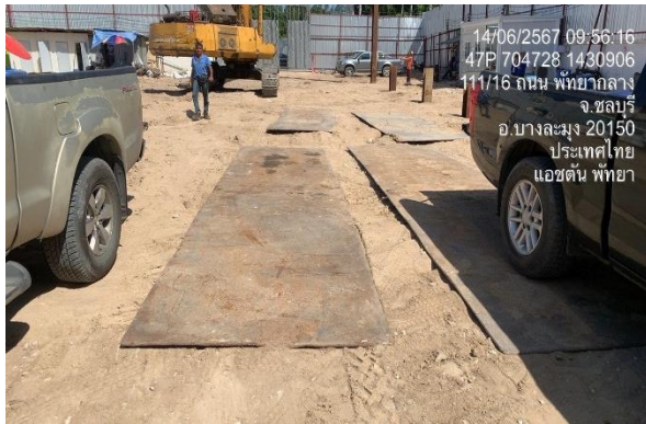
รูปที่ 20 ปูแผ่นเหล็ก
