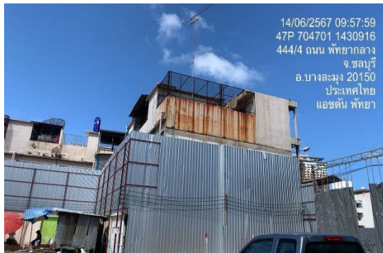
รูปที่ 1 รั้วชั่วคราวเป็นรั้วทึบเมทัลชีท (Metal Sheet)
